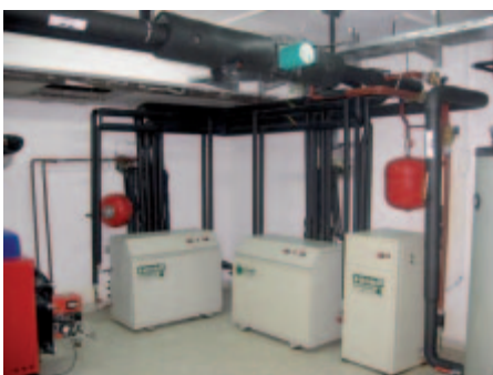
Slika 8, 8a, 8b. Geotermalna toplinska pumpa u privatnoj kući, Skoplje, Makedonija
