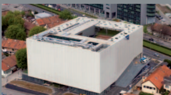
Hitna pomoć - nova zgrada, Zagreb
